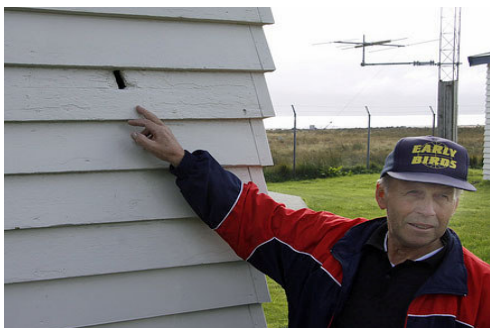
Kulehull fra krigens dager i veggen på den ene bygninga
